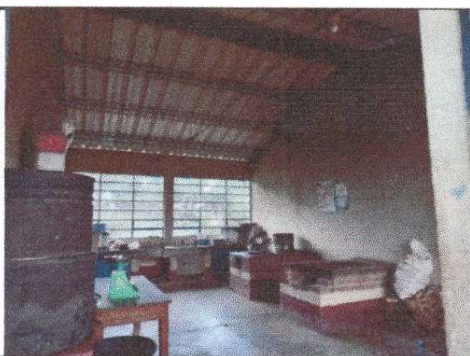
Foto 5: Pintura en muros exteriores e interiores
