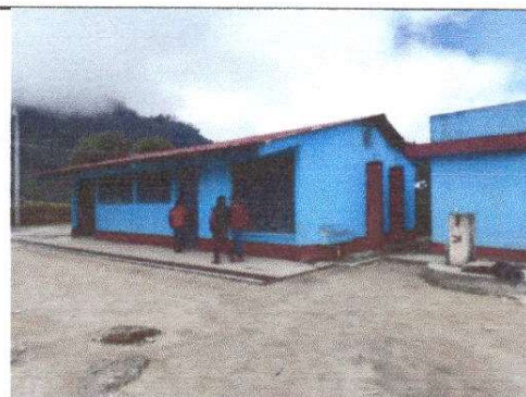
Foto 4: Pintura en muros exteriores e interiores
